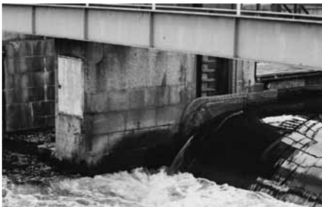
Bild 9: Wehrpfeiler der Staustufe Kupfergraben
