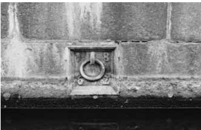
Bild 7: Halteringe der ehemaligen Schleuse von 1862
