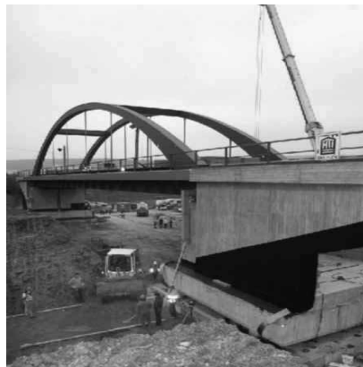
Herstellung des Bauwerkes in Seitenlage
