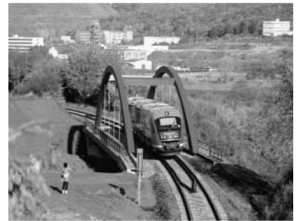
Bauwerk mit Verschiebbahn
