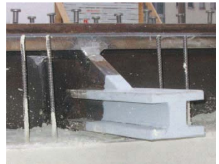
Bild 6. Detail Kopplung vor Betonierzustand
