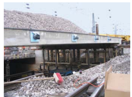
Bild 7. Überbau vor der Absenkphase
