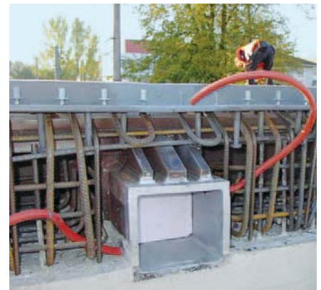
Bild 5. Detail Kopplung vor Betonierzustand
