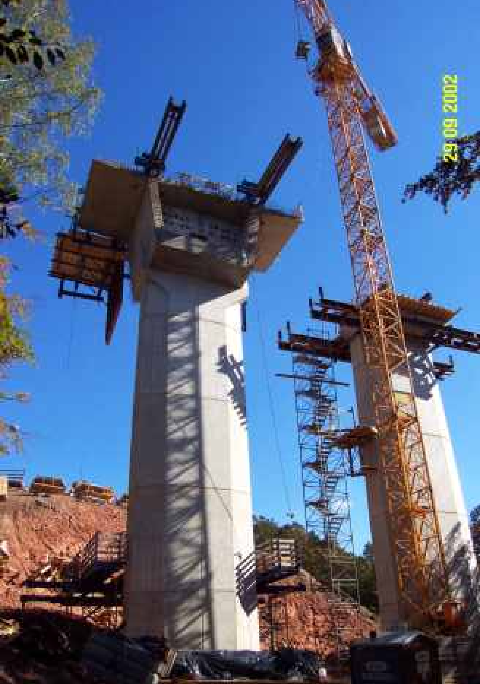
Herstellung der Grundetappe, biegesteife Verbindung Überbau mit Pfeilerkopf
