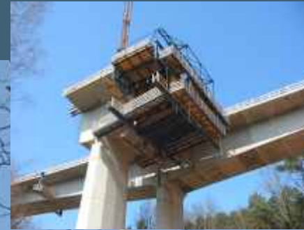
Freivorbau erster Überbautakt
