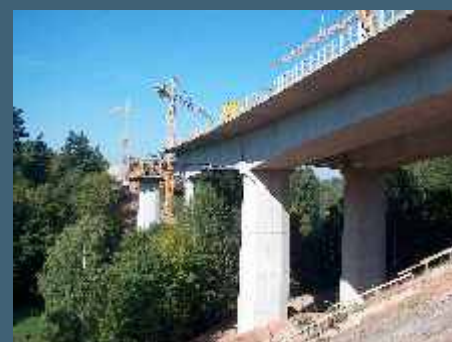
Teilbereich fertiggestellte Brückenhälfte
