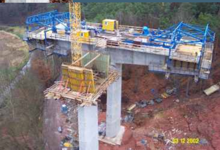
Herstellung der Grundetappe Süd/ Waagebalken Nord
