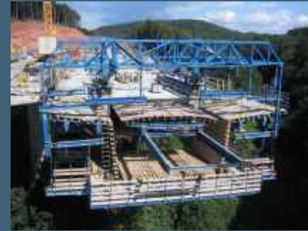
Freivorbaugerät
