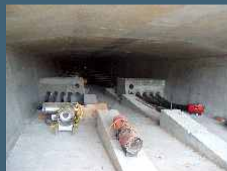
Hohlkasten mit Umlenksattel und Spann- lisenen
