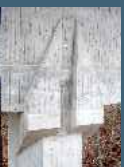
Herstellung der Grundetappe, biegesteife Verbindung Überbau mit Pfeilerkopf
