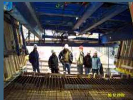
Bewehrung Bodenplatte
