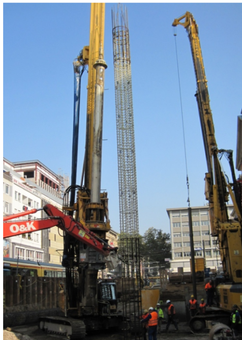
Einbau einer Pfahlbewehrung am Europaplatz
