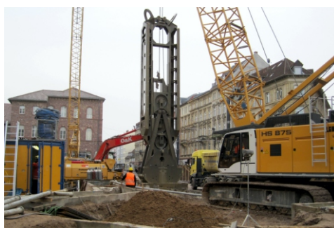
Seilbagger HS 875 mit Schlitzwandgreifer am Kronenplatz
