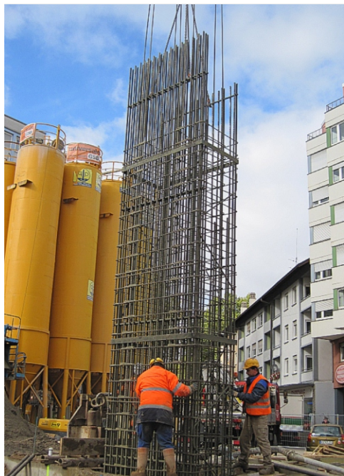
Einbau der Schlitzwandbewehrung am Kronenplatz
