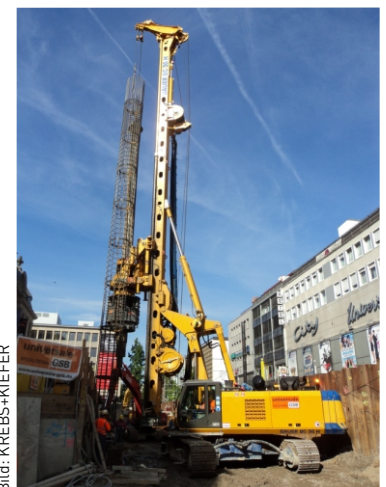
Bohrgerät BG36 beim Einstellen des Bewehrungskorbes eines Bohrpfahles am Europaplatz
