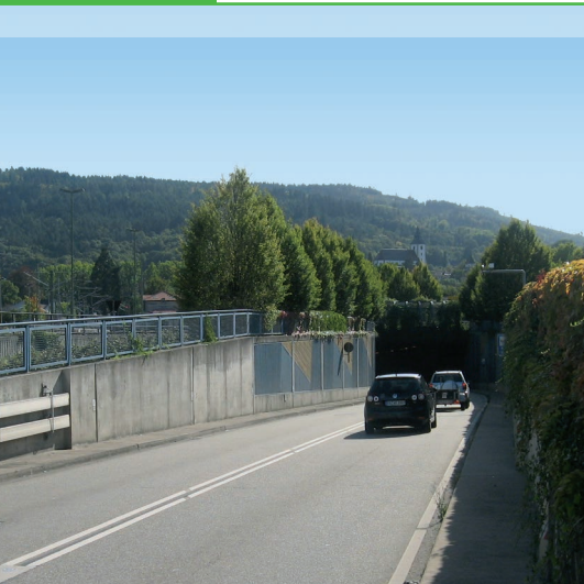
Tunnel Gernsbach B 462, Gernsbach Länge: 1.527 m Abb.: Krebs und Kiefer
