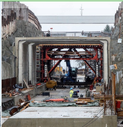
Tunnel Westumfahrung Bautzen B 96, Bautzen Länge: 200 m Abb.: Krebs und Kiefer
