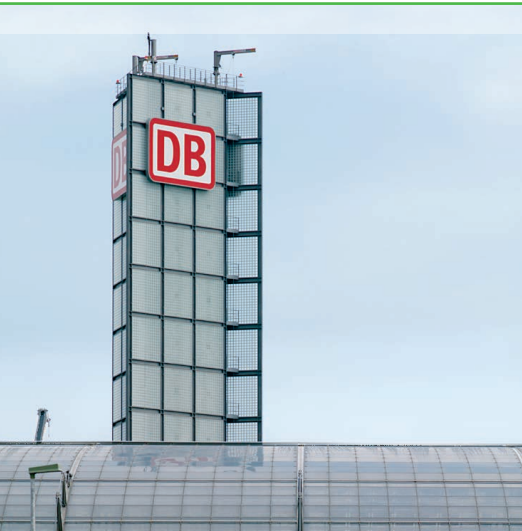
Abluftkamin Tunnel Tiergarten Spreebogen B 96, Berlin Architekten: gmp Architekten von Gerkan, Marg und Partner Abb.: Friedemann Steinhausen Architekturphotographie, Potsdam
