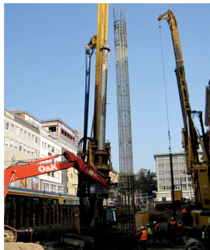
Einbau einer Pfahlbewehrung am Europaplatz
