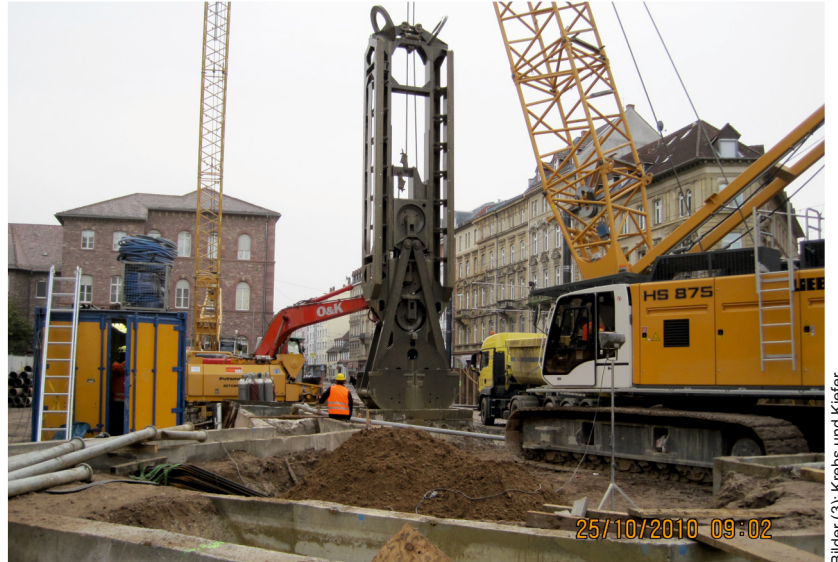
Seilbagger HS 875 mit Schlitzwandgreifer am Kronenplatz
