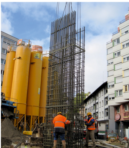
Einbau der Schlitzwandbewehrung am Kronenplatz
