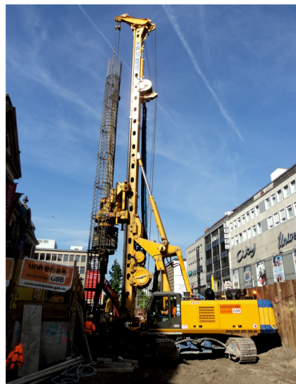
Bohrgerät BG36 beim Einstellen des Bewehrungskorbes eines Bohrpfehles am Europaplatz
