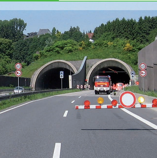
Tunnel Burgholz L 418, Wuppertal Länge: 1.860 m Abb.: Krebs und Kiefer
