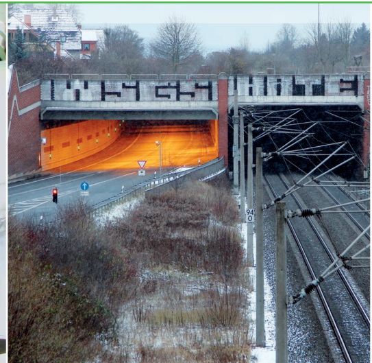
Tunnel Bovenden B 3, Göttingen Länge: 401 m Abb.: Krebs und Kiefer
