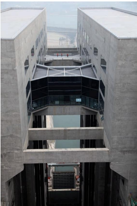
**Bild 17** Leitstand am Bauwerkskopf
