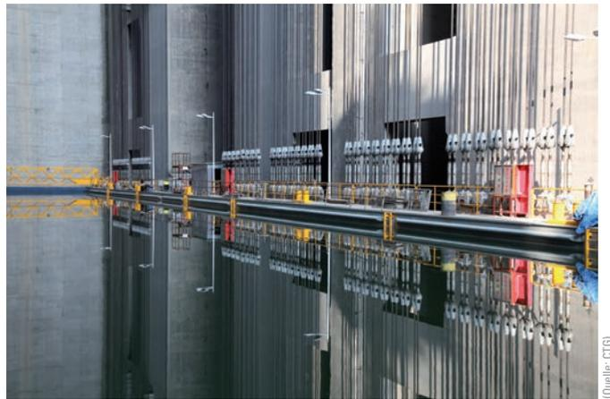
**Bild 14** Wassergefüllter Schiffstrog mit Seilaufhängung
