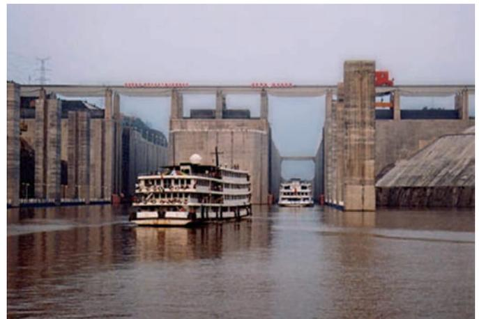
Bild 4. Obere Schleusenzufahrt mit Sicht in die Schleusenkammern der Doppelschleuse
