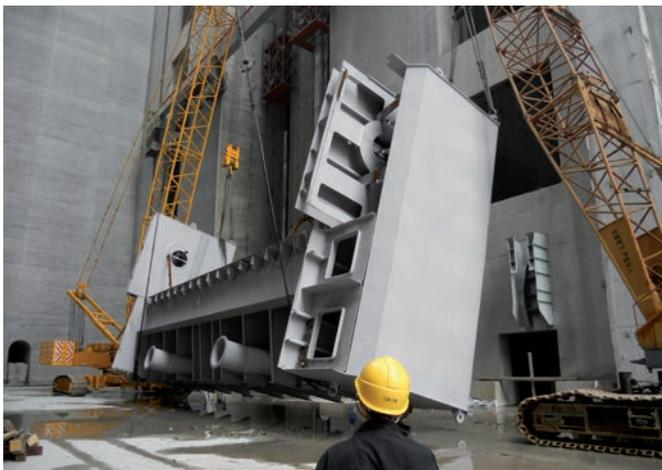
**Bild 12** Segment Schiffstrog
