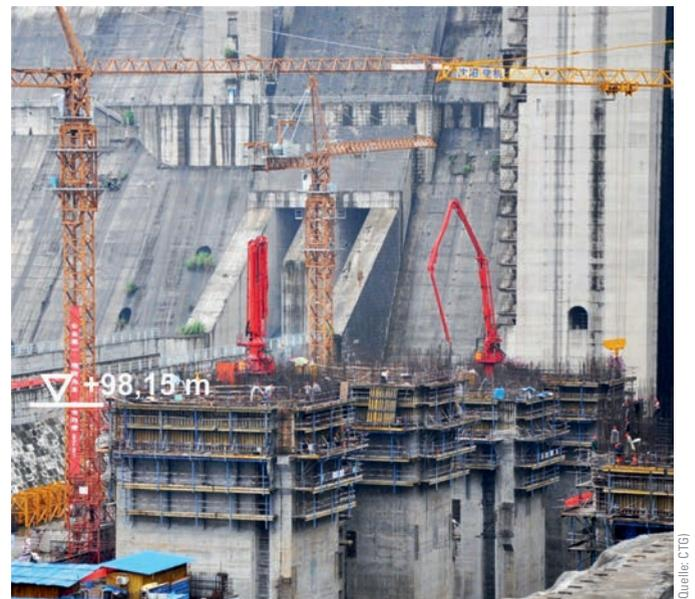
**Bild 9** Kletterschalung Massivbau 2010
