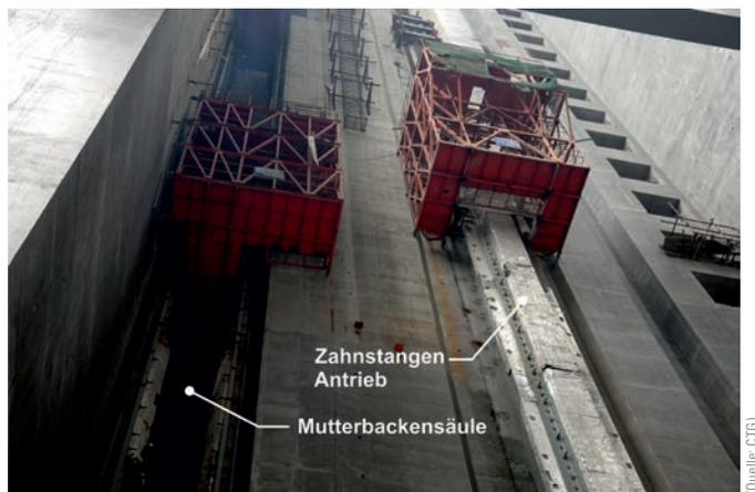
**Bild 15** Montage Zahnleisten Antrieb und Mutterbackensäule 2014
