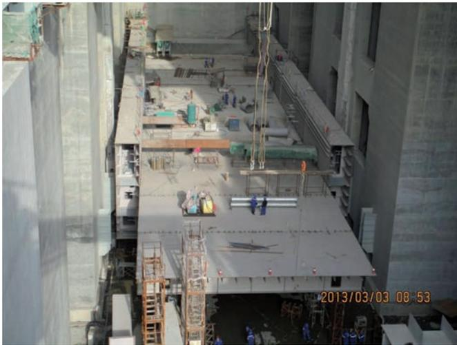
**Bild 11** Montage Schiffstrog zwischen Türmen
