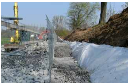
Halbverfüllte Gabionen
