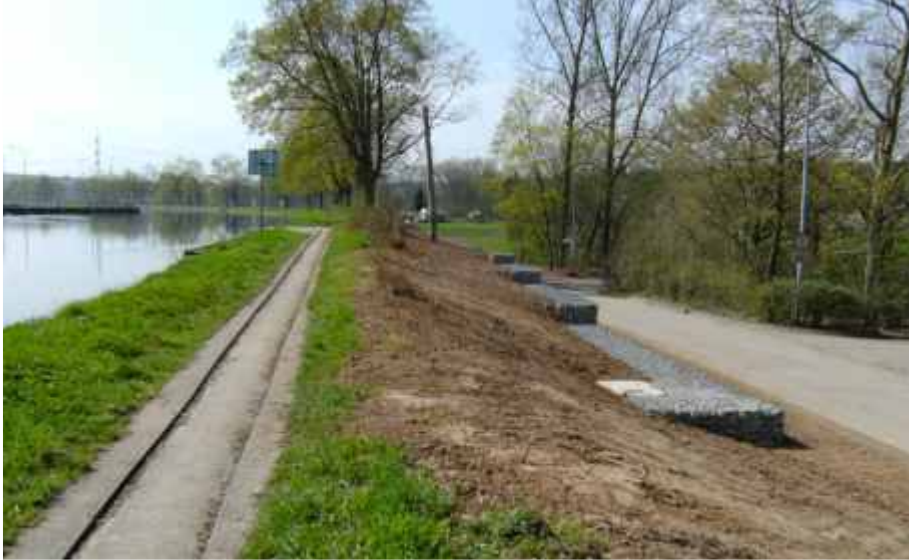
Damm mit fertiggestellten Gabionen am Bauanfang km 117 + 560
