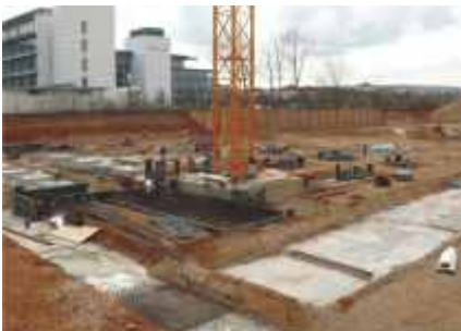
Blick in die Baugrube
