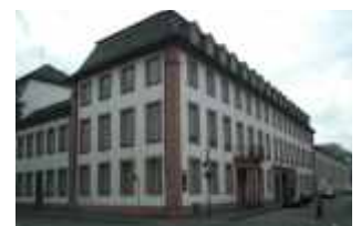
Ansicht der Bestandsfassade
