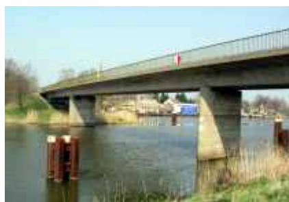
Bestandsbauwerk mit dreifeldrigem Spannbetonüberbau
