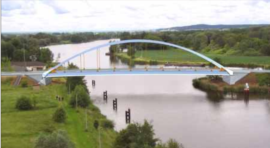
Neubau als Stabbogenbrücke (Visualisierung)
