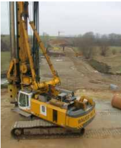
Herstellung der Bohrpfähle, Achse 0
