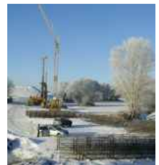
Herstellung der Bohrpfähle Achse 3
