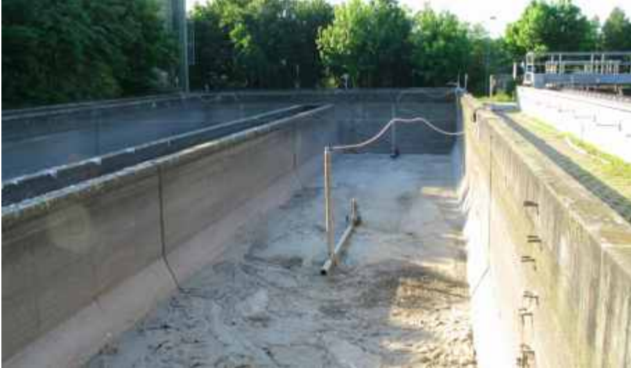
Bestehendes Regenbecken vor dem Umbau
