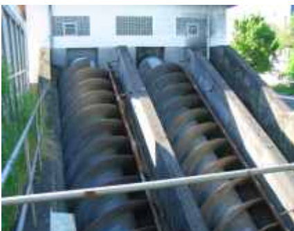
Bestehendes Schneckenhebewerk vor dem Umbau
