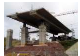
Überhöht hergestellter Überbau
