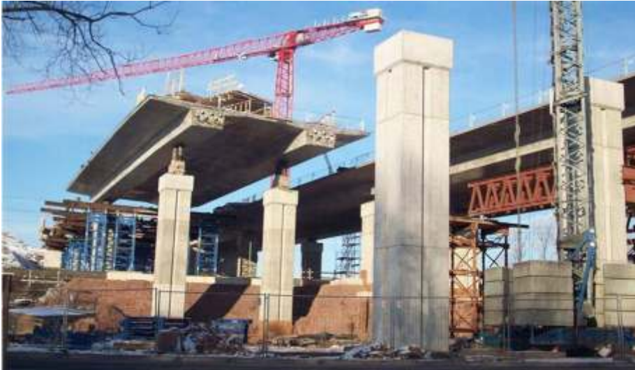
Überhöht hergestellter Überbau
