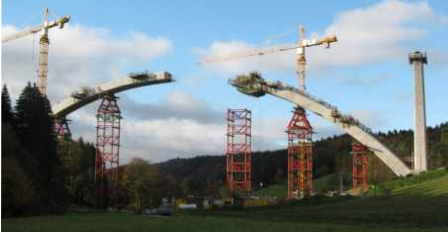
Herstellung Bogen: Freiverbau und Hilfsunterstützungen
