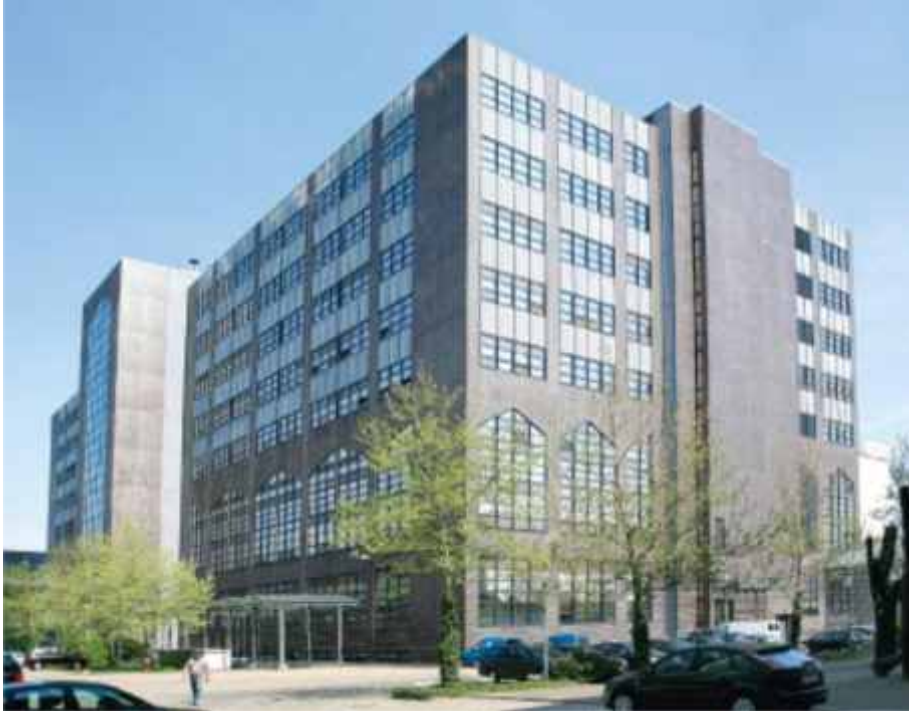
Süd-West-Ansicht des Produktionsgebäudes
