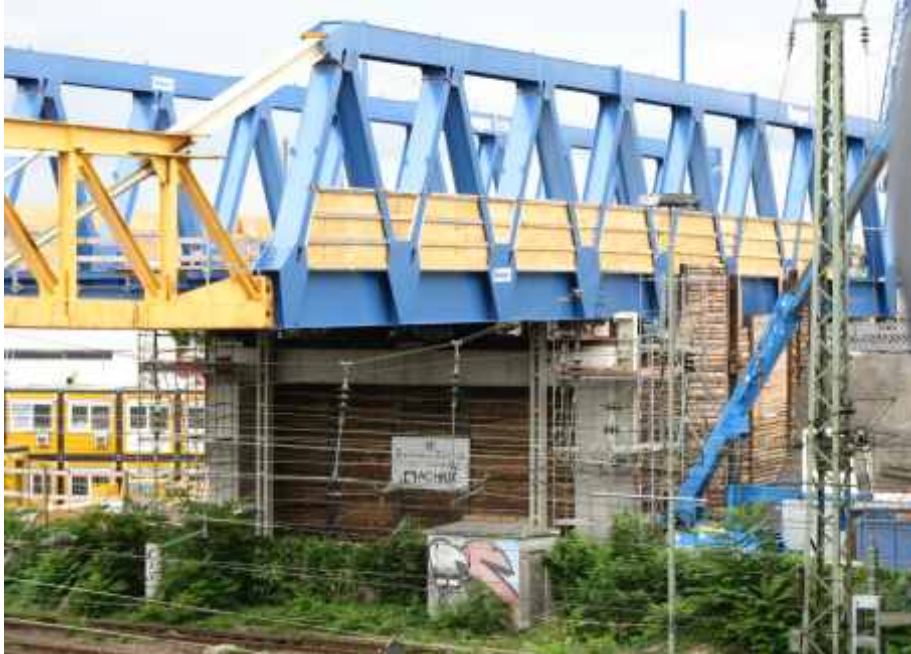
Einschub der Behelfsbrücke (mit Vorbauschnabel)
