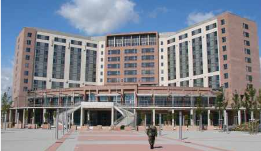
KMCC - Hotelkomplex (Südostansicht)
