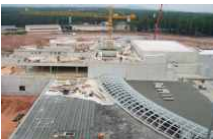
KMCC - Rohbau Mall (hinten Kino-Komplex und vorne Hallway Süd)
