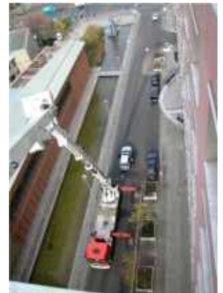
Fassadenbefahrung mit Hubsteiger
