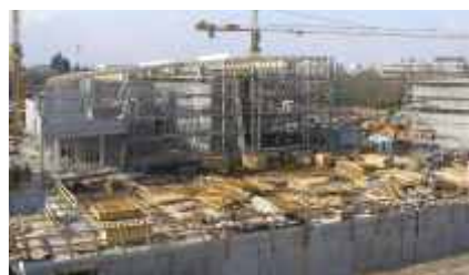
Nordansicht während der Bauzeit
