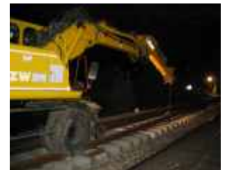
Verlegung der neuen Fahr-schiene
