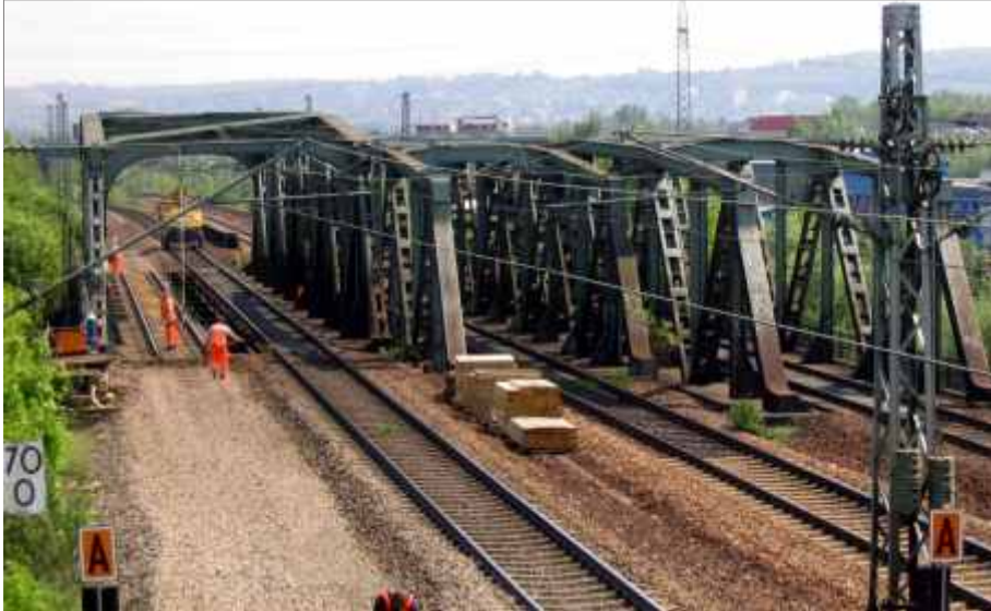
Parallel verlaufende Streckengleise, Strecke 4000 und 4200
