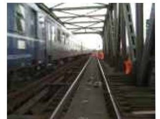
Gleisabstand 3,70 m und zweigleisiger Überbau
