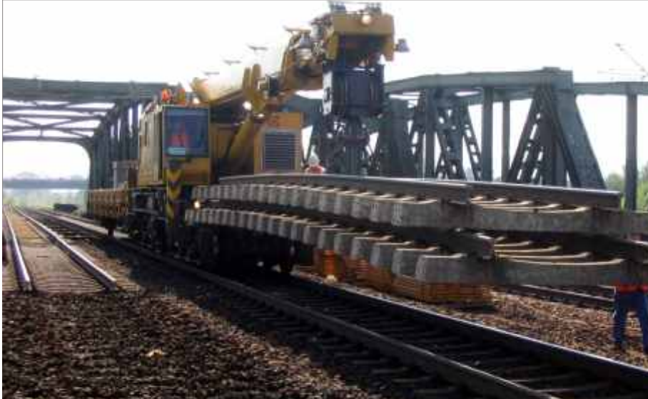
Ausbau der alten Gleisjoche
