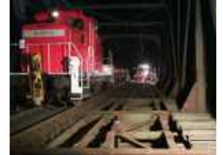
Ausbau der alten Brückenbalken
