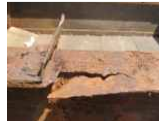
Gerissener Längsträger
