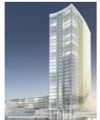
Фасад, высотное офисное здание
