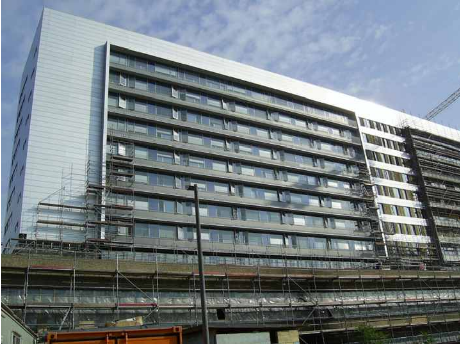
Sanierte Fassade Bettenhochhaus
