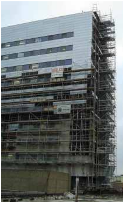
Treppenturm auf Trägerrost und Fassadengerüst auf Konsolvorbauten
