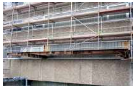
Auskragerender Trägerrost
