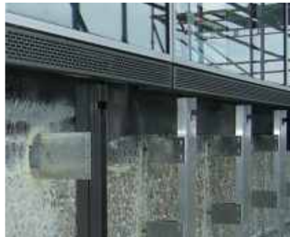
Kernbohrung durch Waschbetonplatten, Fensterband
