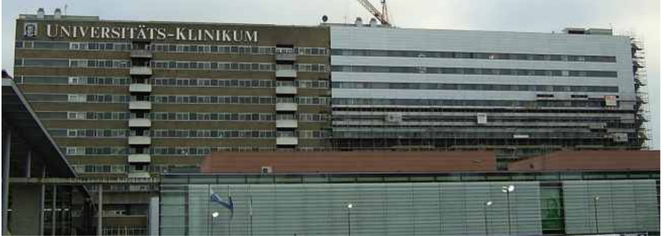
Fassadensanierung in zwei Bauabschnitten
