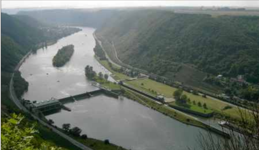
Übersicht Schleuse Lehmen
