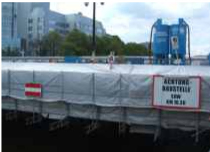
Einhausung für Korrosionsschutzarbeiten
