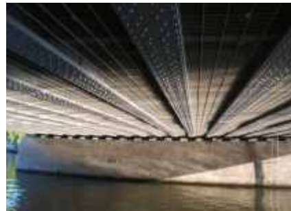
Brückenunterseite nach Sanierung
