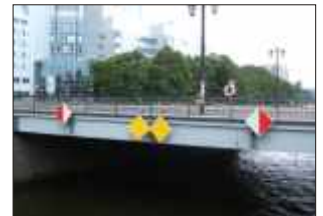
Brückenansicht vor Sanierung
