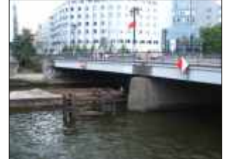
Brückenansicht vor Sanierung
