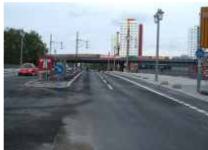
Brückenoberseite vor Verkehrsfreigabe
