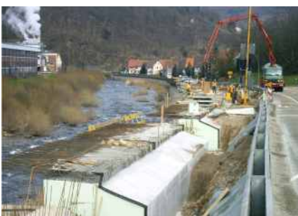
Sanierung Stützwandkopf
