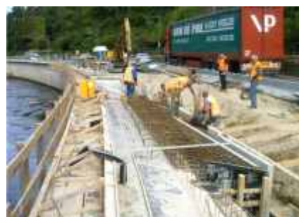
Baustelle mit einstreifiger Verkehrsführung
