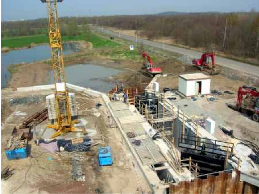
Bauzustand Schleuse im Frühjahr 2006
