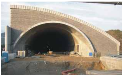
Portal West der Südröhre (Bauzustand)
