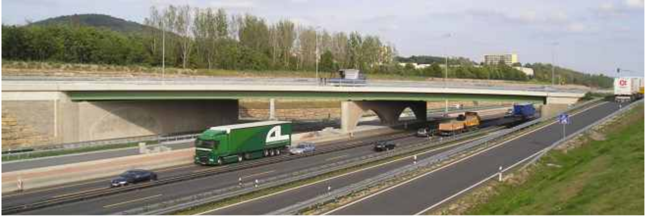
Ansicht Bauwerk, Verkehrsführung 4+0
