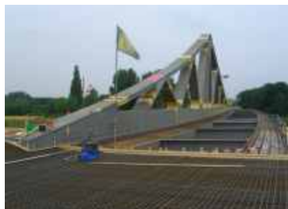
Herstellung der Verbundplatte
