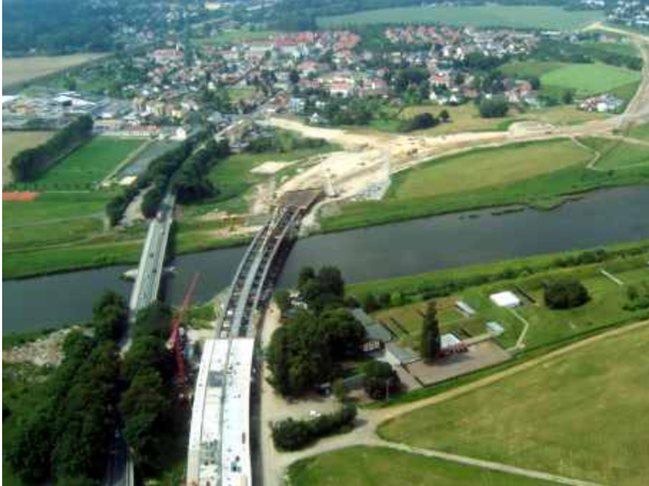
Brücke über die Mulde vor Bennewitz
