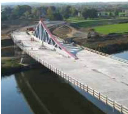
Tragwerk mit Stahlverbundplatte
