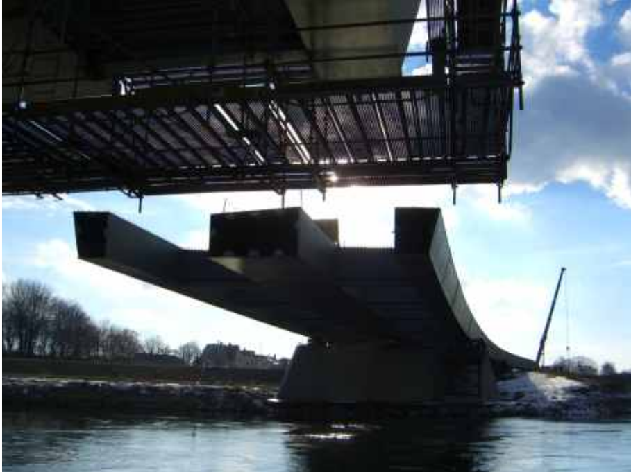
Flussbrücke beim Vershub
