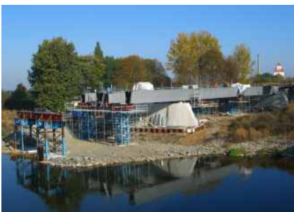
Bauabschnitt am östlichen Muldeufer
