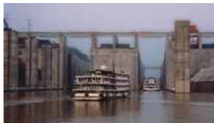
Obere Schleusenzufahrt mit Sicht in die Schleusenkammern der Doppelschleuse
