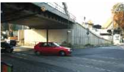
Widerlageransicht Neubau Richtung Bahnhof Pankow
