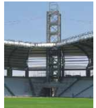
Pylon im Bauzustand
