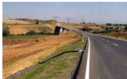
B 180n mit Bauwerk
