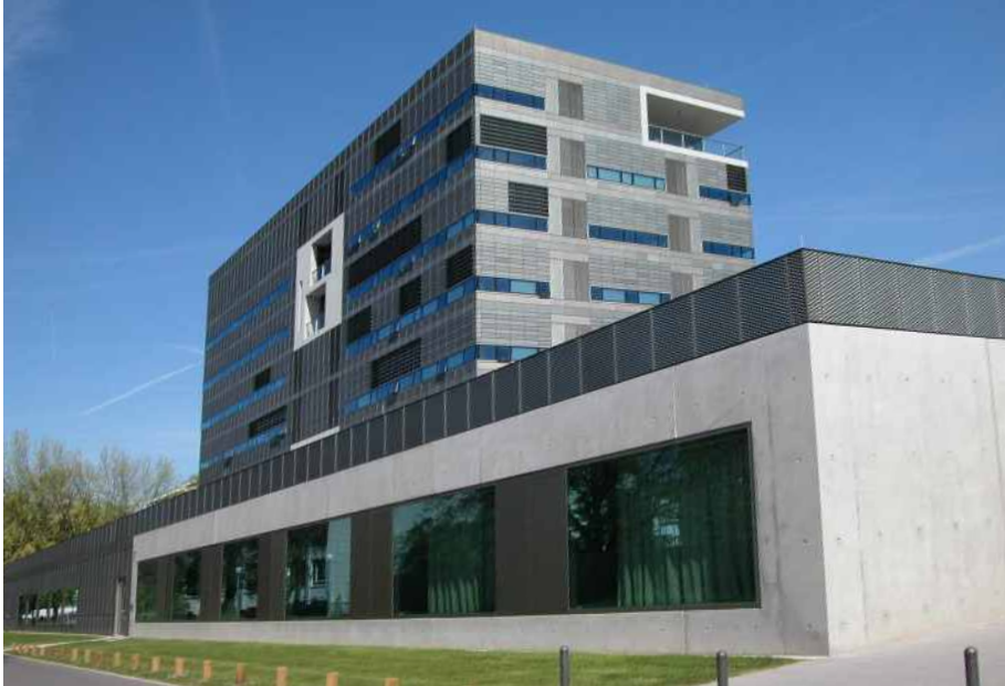
Ansicht Gebäude BIOQUANT
