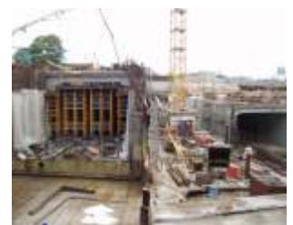
Rohbau am Hauptbahnhof
