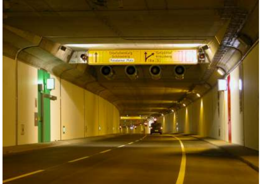
Fertig ausgerüsteter Tunnel
