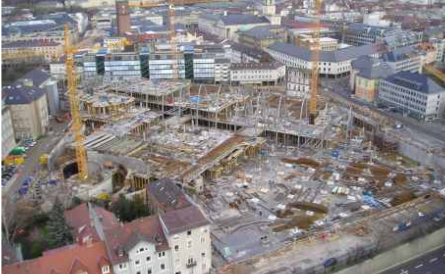
Luftbild der Baustelle
