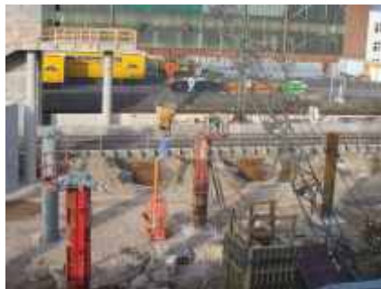
Ausführung der Stützen für die Überbauung zwischen Gleisanlagen und B 62
