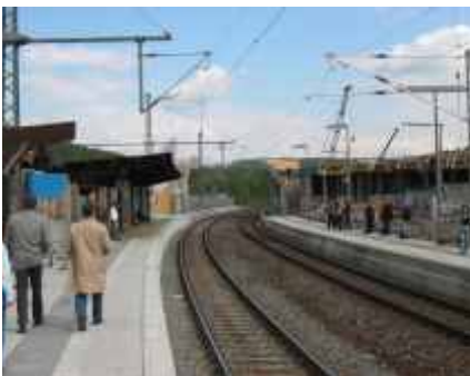
Neue Bahnsteige an den beiden Hauptgleisen. In Bildmitte die neuen Treppenanlagen (im Bauzustand) für den späteren Zugang zu den Bahnsteigen
