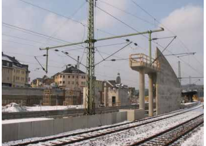
Zugang zum Mittelbahnsteig im Rohbau
