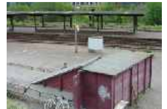
Bestehende Bahnsteiganlagen mit überdachtem Zugang zum Bahnsteig vor Baubeginn
