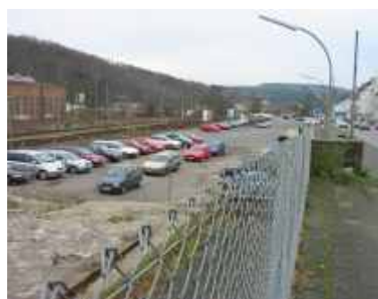
Park and Ride vor Baubeginn
