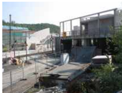
Ansicht der Überbauungen der geplanten B 61 mit Ladenpassage im Rohbau
