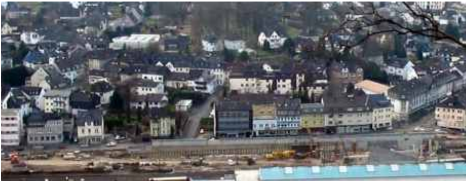
Bauausführung in der ersten Bauphase
