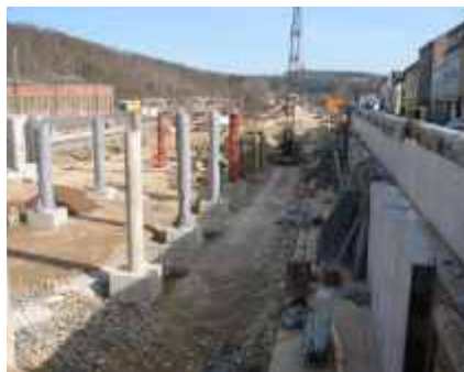
Gründungsarbeiten für die Überbauung des ZOB und der B 62
