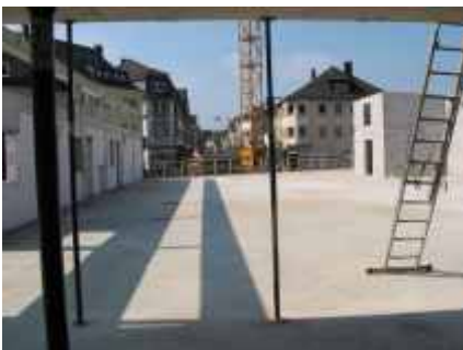
Blick von der Ladenpassage (Rohbau) in Richtung Rathausstraße
