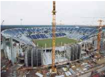
Haupttribüne im Bau
