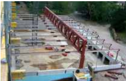
Stahltragwerk der Sporthalle mit Fachwerkbinder
