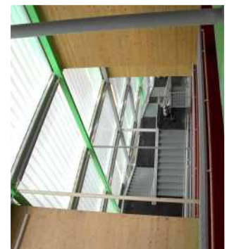
Luftraum hinter der Südfassade mit „Lernboxen“ und Stahltreppe
