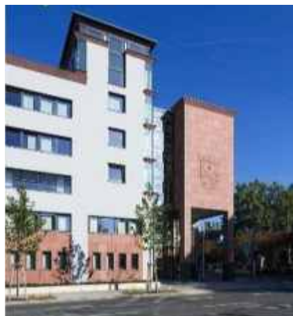
„Turm“ an der Gebäudeecke, 1. BA
