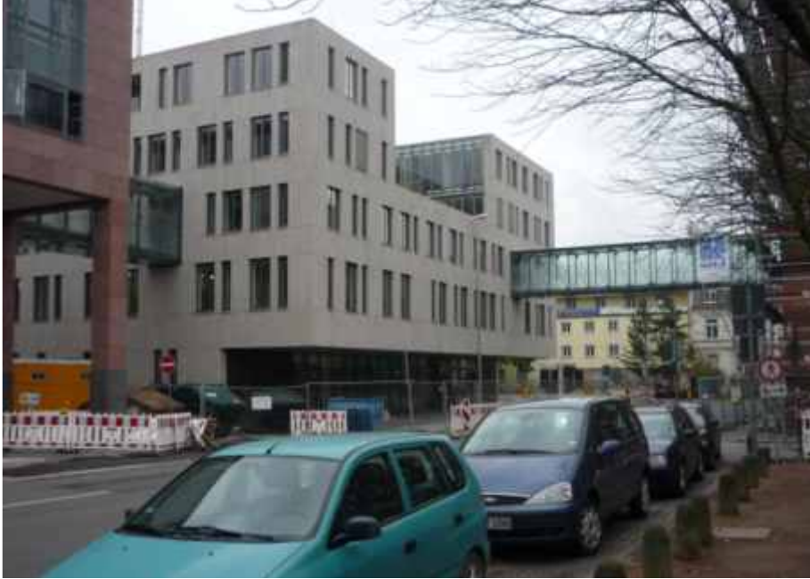
2. BA mit neuen Fußgängerbrücken zum 1. BA (links) und 3. BA (rechts)
