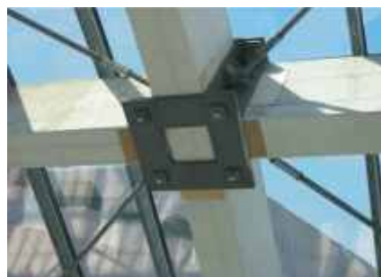
Sanierung der Knotenpunkte
