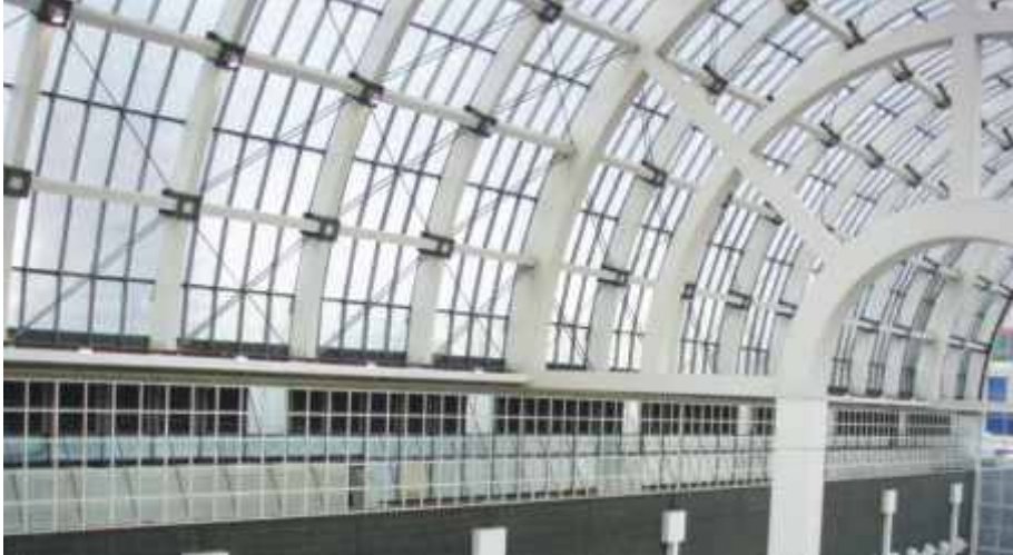
Galeria-Blick in das Tonnengewölbe
