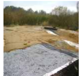
Herstellung der Arbeitsebene
