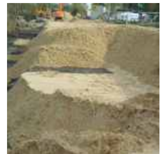
Herstellung des Dammes
