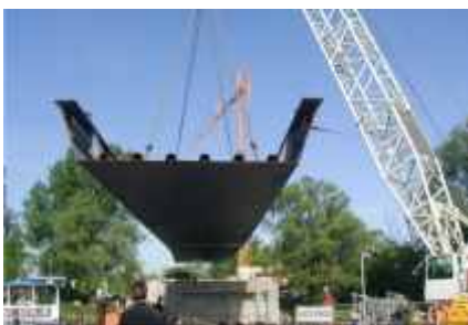
Montage der vorgefertigten Stahlkonstruktionen
