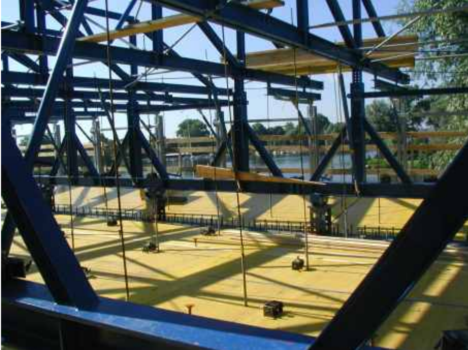
Schalwagen zur Herstellung der Fahrbahnplatte
