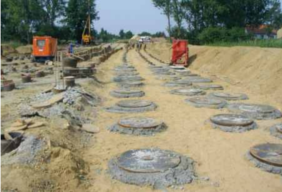
Tiefgründungen mit ausbetonierten Stahlrammpfählen
