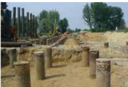
Spezialgründung Straße mittels ausbetonierten Stahlrohren
