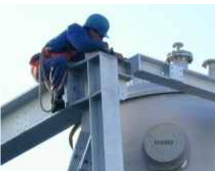
Stahlbaumontage der Produktion
