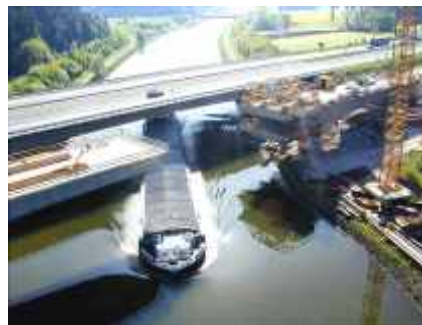
Bauzustand: links fertig und rechts im Freivorbau
