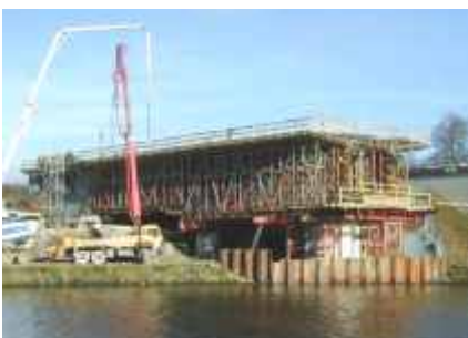
Ansicht Rüstung des Endfeldes
