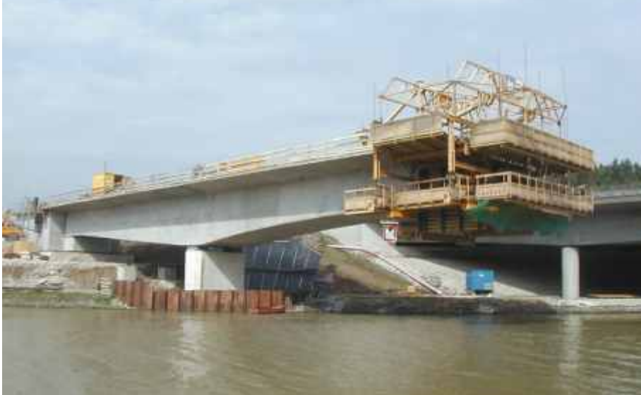
Ansicht Freivorbau über den Main-Donau-Kanal
