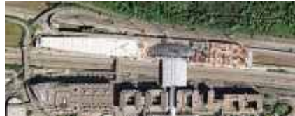
Vogelperspektive während der Bauphase
