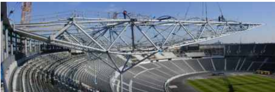
Монтаж стальной несущей конструкции
