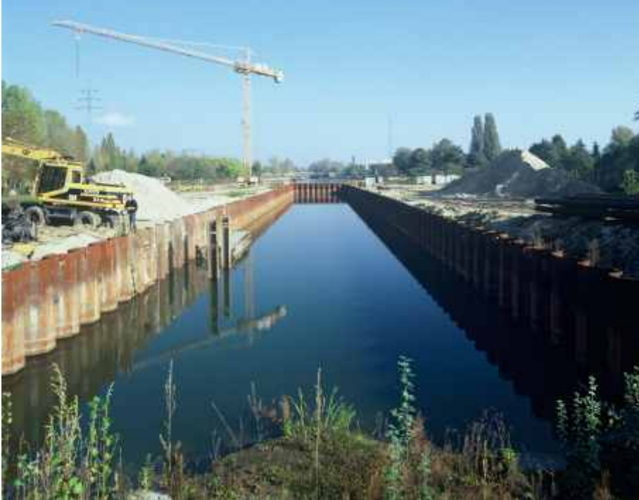
Schleusenammer vor Einbau des Oberhauptes
