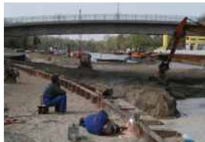
Aushub des unteren Vorhafens
