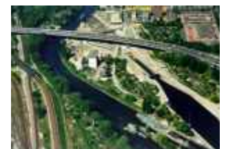
Luftbild: unten alte Schleuse, rechts neue Schleuse
