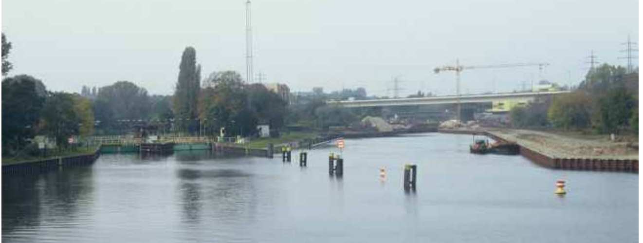
Oberer Vorhafen alte Schleuse (links) und neue Schleuse (rechts), im Hintergrund Rudolf-Wissell-Brücke
