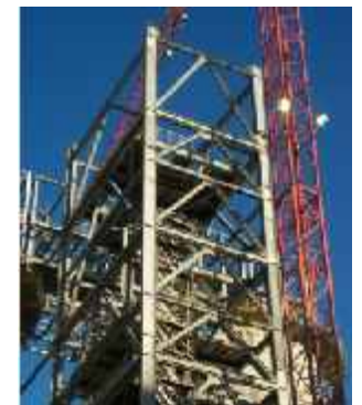
Becherwerksturm im Bau
