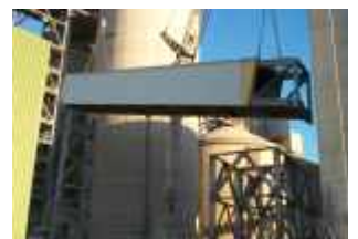
Einheben einer Bandbrücke
