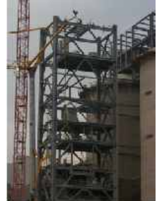
Montage Becherwerksturm
