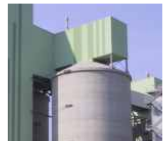
Klinkersilo 11 mit Aufbau
