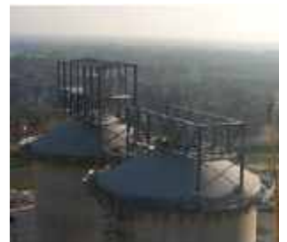
Siloaufbauten auf Silos 10/11
